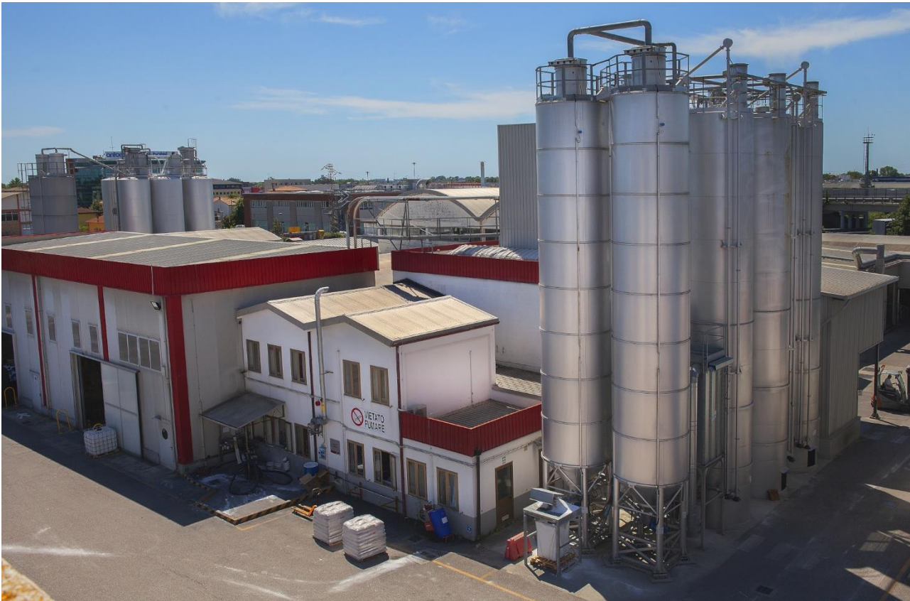
Figura 2: Cisterne nello stabilimento produttivo di San Marco Group.
